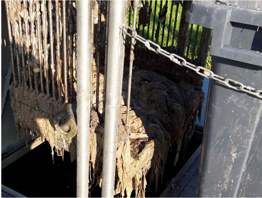
Odstranjevanje vlažilnih robčkov, higienskih vložkov in plen iz kanalizacije.
